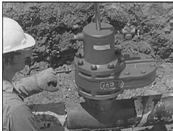
Ábra 10. Belső bypass a POLYSTOPP® 10" tolózáron (tolózárr konstrukció 2019 szeptember után megváltozik)
