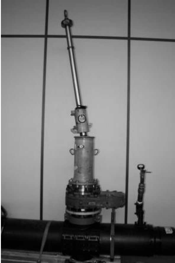
Ábra 38. Záróberendezés felszerelése (tolózár konstrukció 2019 szeptember után megváltozik)
