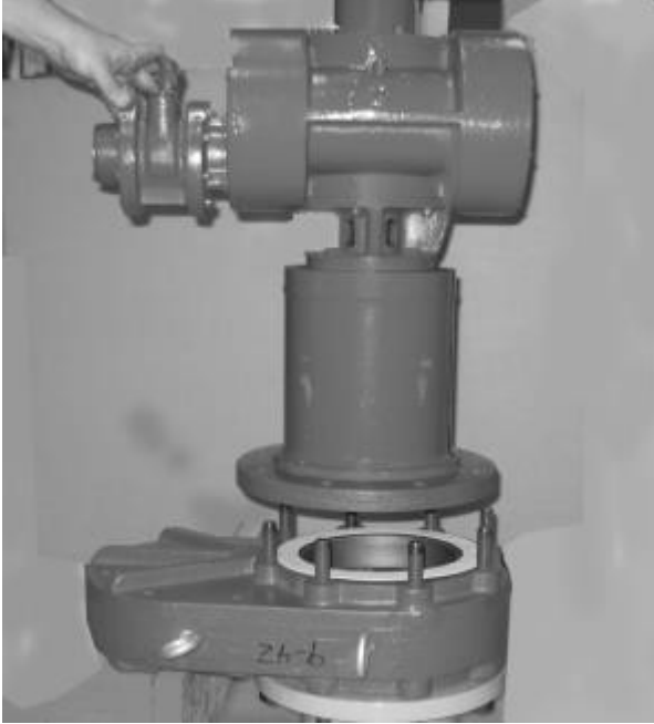
Ábra 22. T-203 megfűró berendezés felszerelése (tolózár konstrukció 2019 szeptember után megváltozik)
