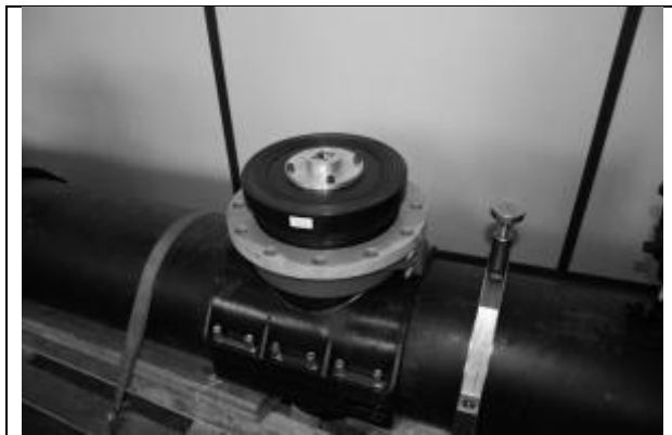
Ábra 54. - A POLYSTOPP® 10" tolózár, megerősítő gallér és tolózár támaszték eltávolítása
